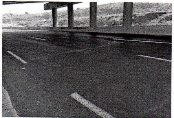
COMENTARIOS: Vista general de la construcción de la carpeta asfáltica.
