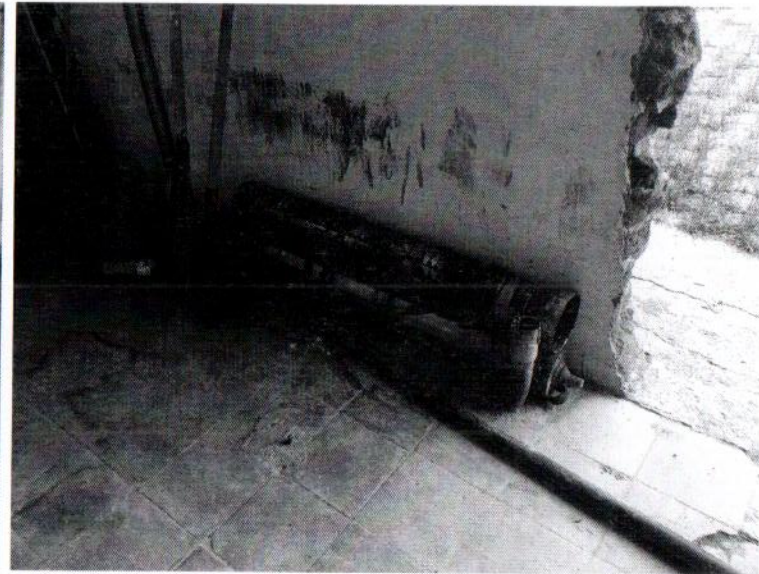
ANTIGÜA BOMBA SUSTITUIDA EN EL POZO CHIHUAHUA
