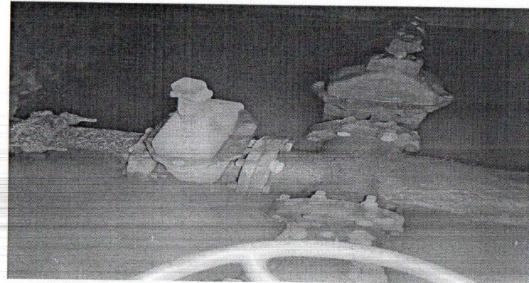
Apertura de caja de válvulas, donde se verificaron la conexión de línea mediante piezas especiales y diámetros de tubería.
