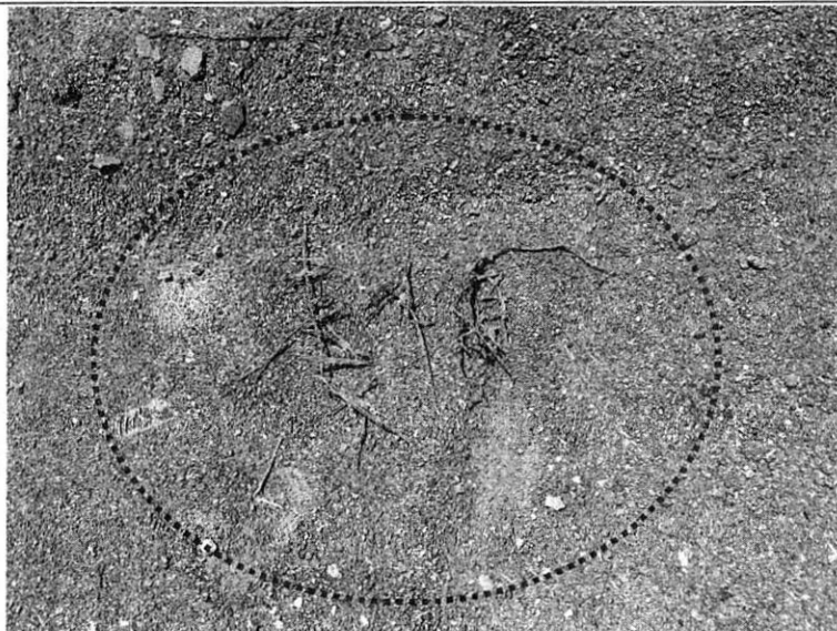
Indicios de la colocación de la geomalla bidireccional.
