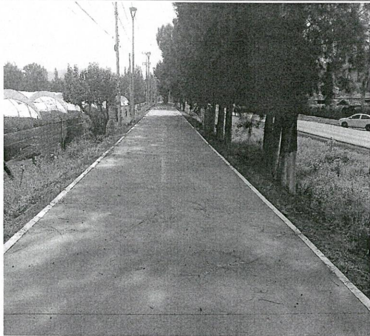
"Construcción de Ciclovía a base de Banqueta de Concreto F'C= 150 Kg/Cm2 de 8 cm. de espesor, Machuelos, Señalética, Luminarias LEDS y Construcción de "Cajas" Guardabicicletas"
