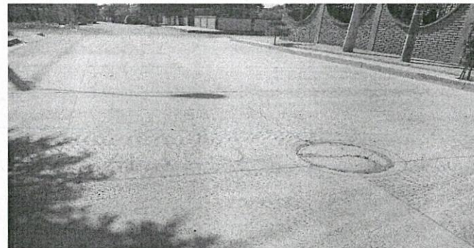
Pavimentación de concreto hidráulico en calle Carrillo Puerto con sustitución de red de drenaje, entre Arboleda y Ferrocarril.
