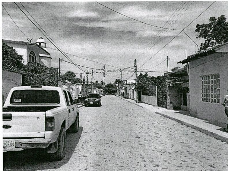
"Empedrado ahogado en mortero de tramo de la calle Emiliano Zapata, entre la calle Degollado y calle Niños Héroes, en la colonia Centro Ixtapa".
