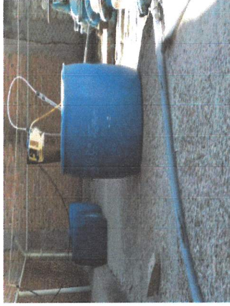
Suministro de insumo a base de Hipoclorito de sodio al 13% en el Pozo "la Normal"
