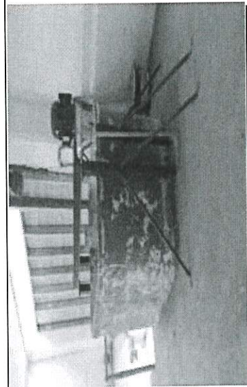
Acción 13, Sustitución de agitador de cal de acero inoxidable.
