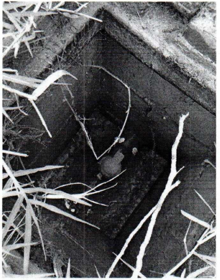
Válvula de admisión y expulsión de aire
