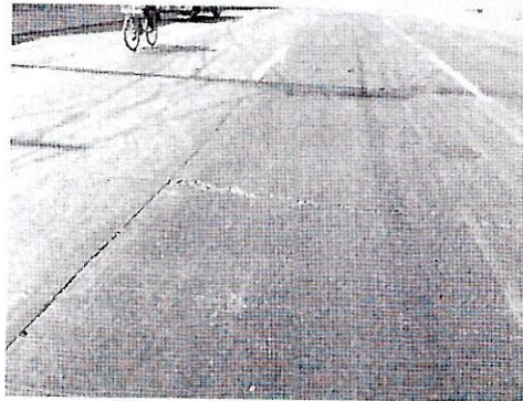
Losas de concreto hidráulico dañadas en Avenida Francisco Zarco
